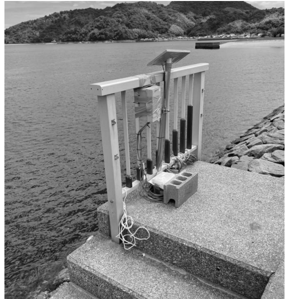
図4 伊保田港付近のノード設置状況
