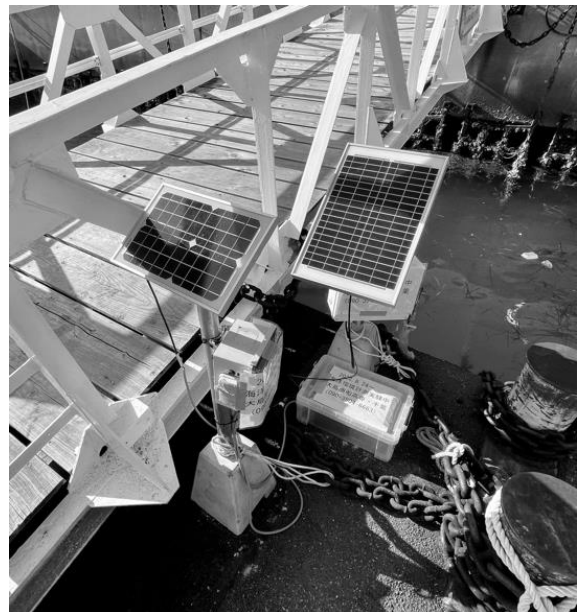
図5 浮棧橋付近のノード設置状況
