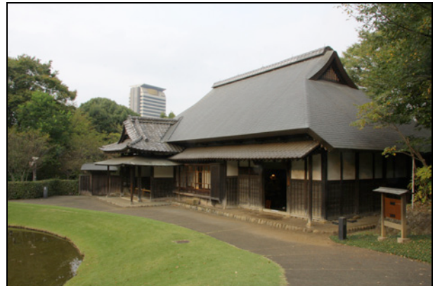
図 1. 旧富澤家住宅 (撮影日:平成 21 年 9 月 27 日)
