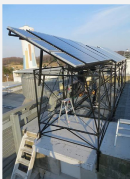
屋上に設置した太陽光発電設備
