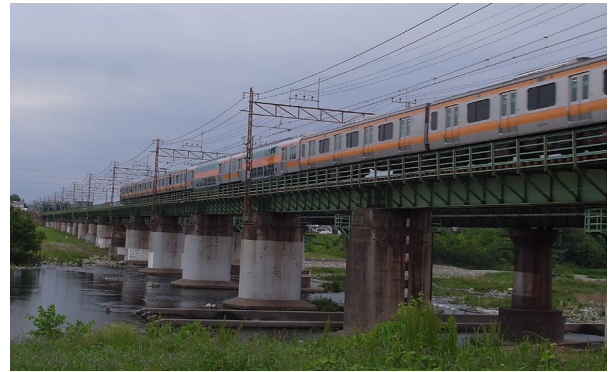
図3 開業時から現存する多摩川橋梁(日野側から)
