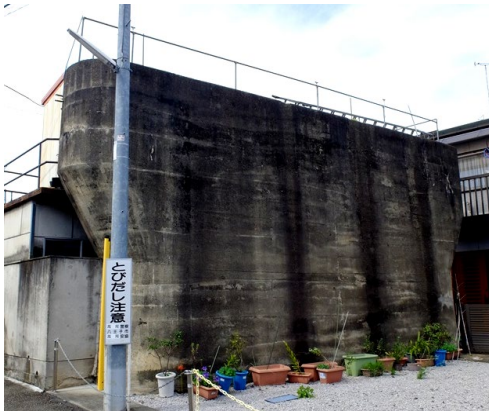
図3 現存する御陵線の橋脚(2)(2019年)
