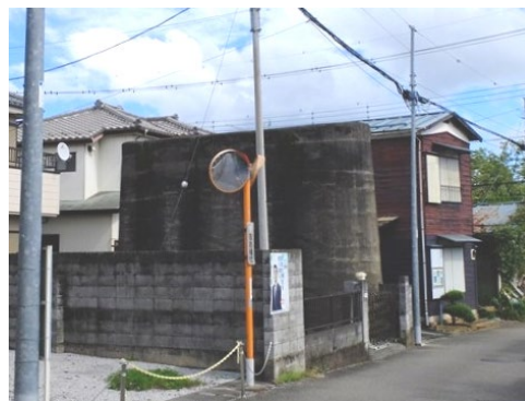
図2 現存する御陵線の橋脚(1)(2019年)
