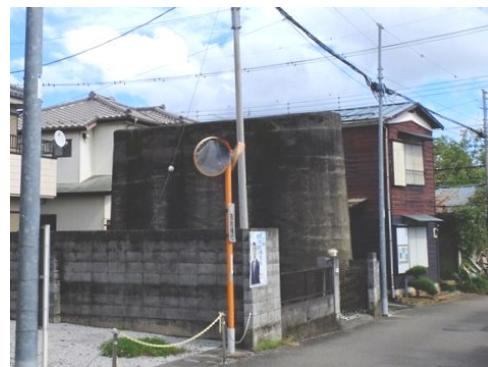
図2 現存する御陵線の橋脚(1)(2019年)
