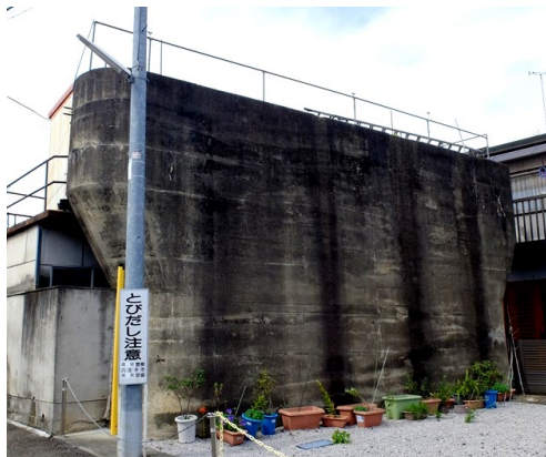
図3 現存する御陵線の橋脚(2)(2019年)
